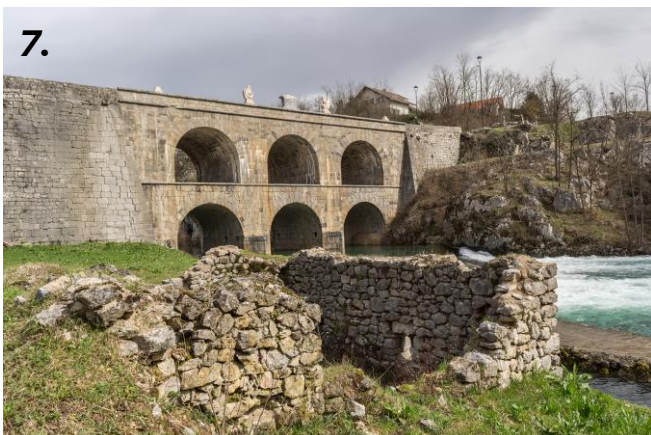
Slika 7. – Jedan od mostova na Jozefinskoj cesti
